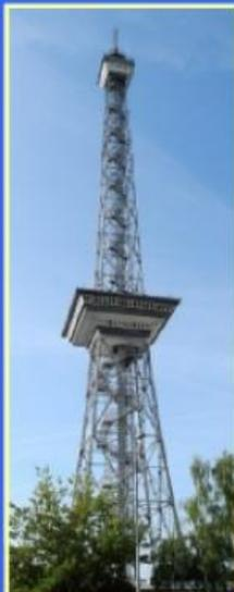
Links: Der Berliner Funkturm sendete ab ca. 1926 zusätzlich zum Voxhaus das Rundfunkprogramm der "Funkstunde" aus. Zeitweise war der gesamte Funkturm die Sendeantenne (er stand deshalb auf Porzellanisolierungen). Aber eine Drahtantenne mit Hilfsmast brachte bessere Ergebnisse.
